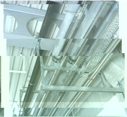
O型管卡固定管道应用
